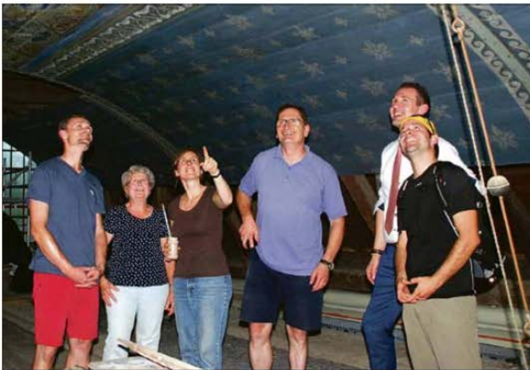
Die Vertreter der Leader-Arbeitsgruppe schauen sich das Tonnengewölbe in der Wulferstedter Kirche an, welches gerade farblich saniert wird.
