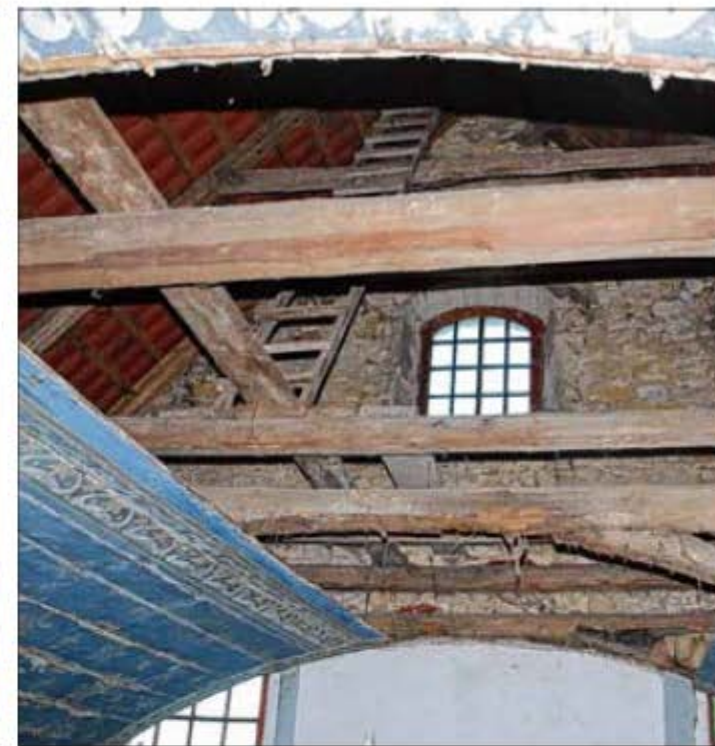
Nach der Entfernung der Fichtenbretter ist der Blick auf das Dach und die Balkenkonstruktion möglich.
