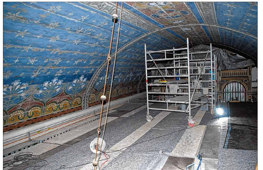
Ein Blick in das Tonnengewölbe der Martinikirche. Nur durch ein gewaltiges Gerüst im Kirchenschiff ist der Zugang möglich geworden.
