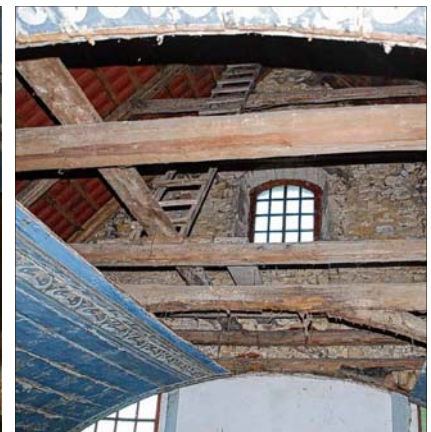
Nach der Entfernung der Fichtenbretter ist der Blick auf das Dach und die Balkenkonstruktion möglich.
