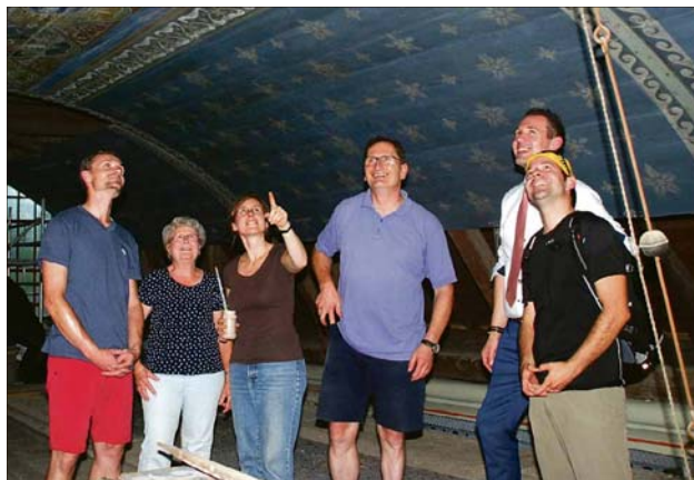
Die Vertreter der Leader-Arbeitsgruppe schauen sich das Tonnenengewölbe in der Wulferstedter Kirche an, welches gerade farblich saniert wird.
