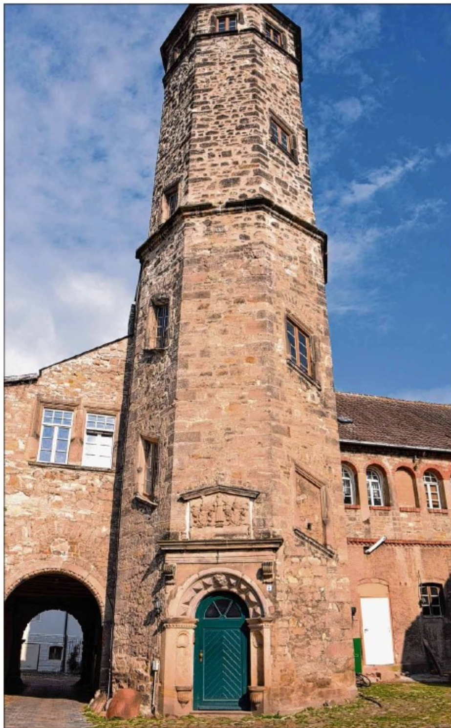
Am kommenden Sonntag sind Besucher auf dem Burggelände zum Aufstieg auf den Turm willkommen. Rechts neben dem Turm (weiße Tür) entsteht die Toilettenanlage.
